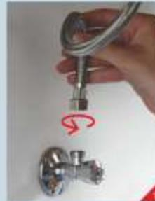
▶ Schlauch, der unter der Spüle zur Armatur führt, von der Kaltwasserzufuhr (Eckventil) lösen
