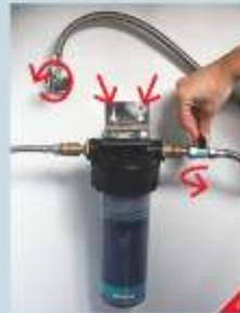
Nun den Wasserhahn an der Spüle schließen und das Filtergehäuse entlüften: Lappen auf das Entlüftungsventil (weiß) am Gehäusedeckel legen und mehrmals kurz auf den Knopf drücken, bis etwas Wasser austritt. Wasser rund fünf Minuten durch den Filter laufen lassen, um die Filterpatrone zu aktivieren. Dabei kann etwas Kohlenstaub ausgespült werden. Dies ist normal und unbedenklich.
