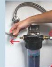
Damit das gefilterte Wasser immer sauber und frisch bleibt, muss die Filterpatrone nach sechs Monaten gewechselt werden. Der beiliegende Aufkleber dient als Erinnerung an den Wechsel.
