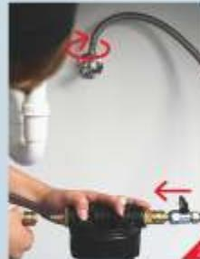
▶ Der Filtergehäuse-Eingangsschlauch wird installiert: Schnellkupplungsstecker an der »IN«-Seite des Filtergehäuses in die Kupplung einrasten lassen, anderes Schlauchende am Eckventil der Kaltwasserzufuhr fest verschrauben.
